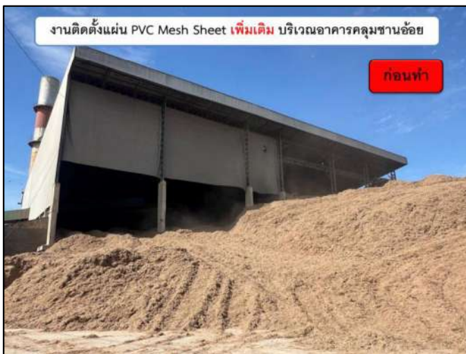
รูปภาพ การติดตั้ง PVC Mesh Sheet อาคารคลุมขานอ้อย
