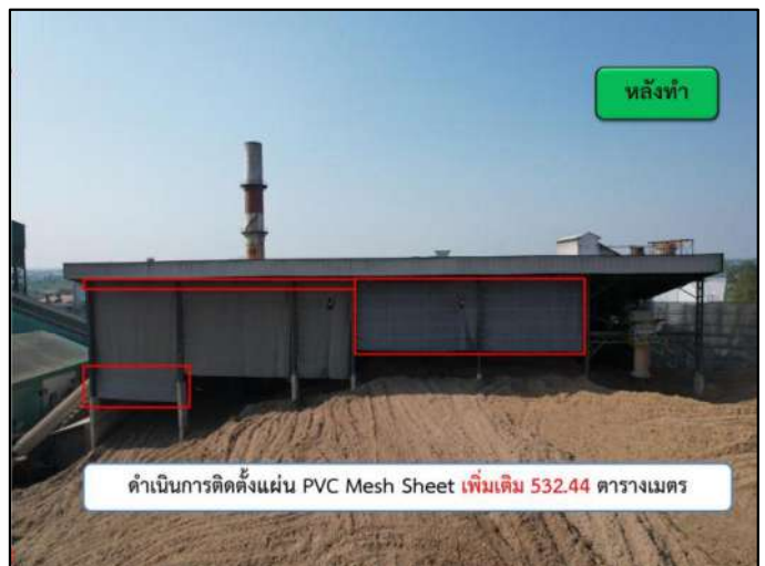
รูปภาพ การติดตั้ง PVC Mesh Sheet อาคารคลุมขานอ้อย
