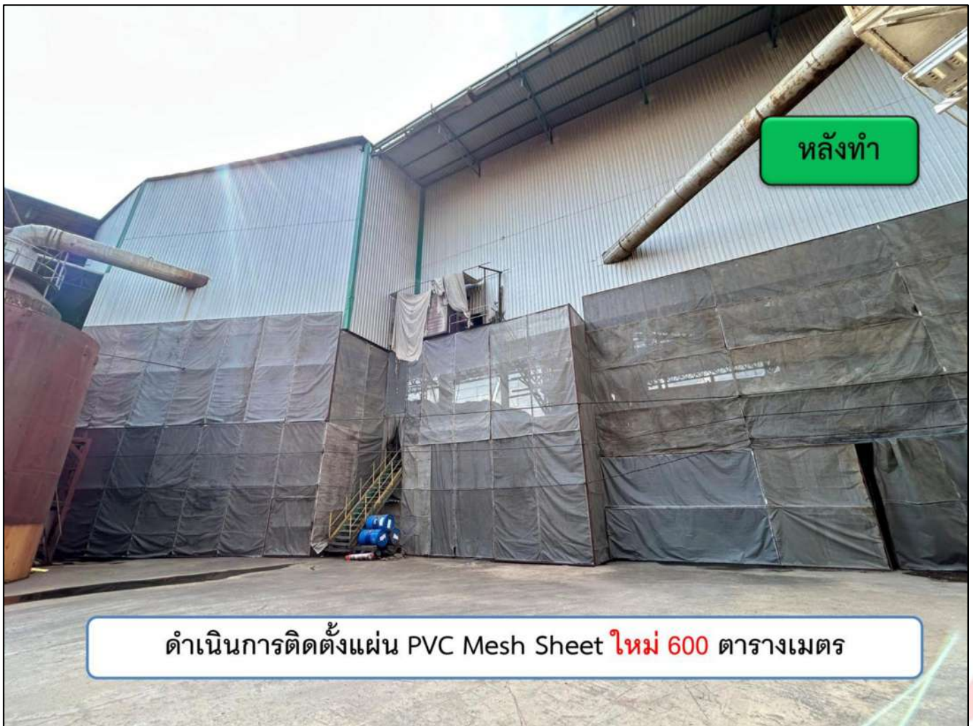
รูปภาพ การติดตั้ง PVC Mesh Sheet บริเวณหลังตะกาวโรงไฟฟ้า
